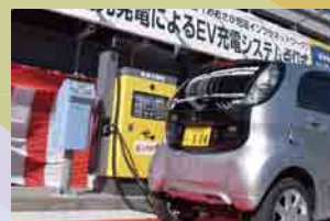
電気自動車（EV）の充電器設置
