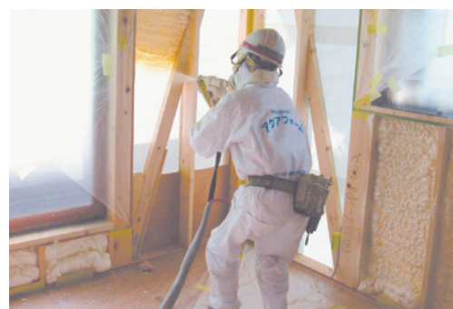
吹き付け施工の様子
