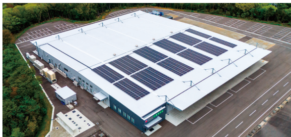
ヤマダ西日本リユースセンター山口工場
