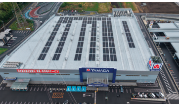
LIFE SELECT 前橋吉岡店の店舗屋上太陽光パネル
