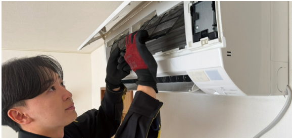
セールスエンジニアのエアコンクリーニングの様子
