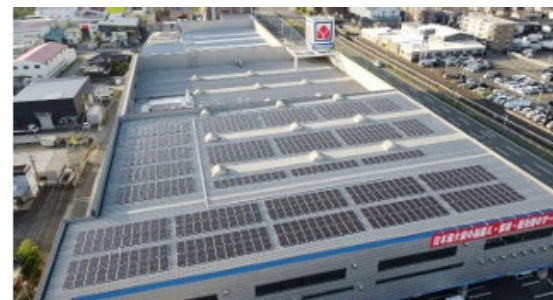
▲ 店舗屋上への太陽光発電パネル設置の様子
