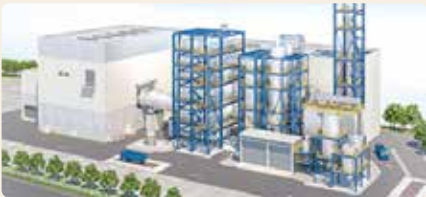
高効率の廃棄物発電プラントの新設 処理能力86,000トン／年間 発電能力62,000MW／年間
